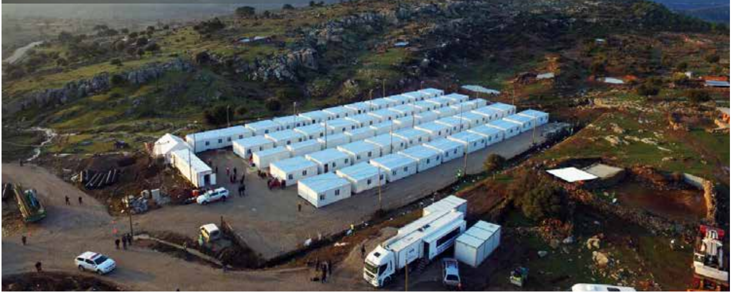
Çanakkale Earthquake Field - 700 Man Camp Deprem Bölgesi - 700 Kişilik Yaşam Kampı
